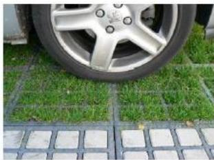
*Dalle alvéolaire (béton ou plastique) - Source : Sol-aire*
